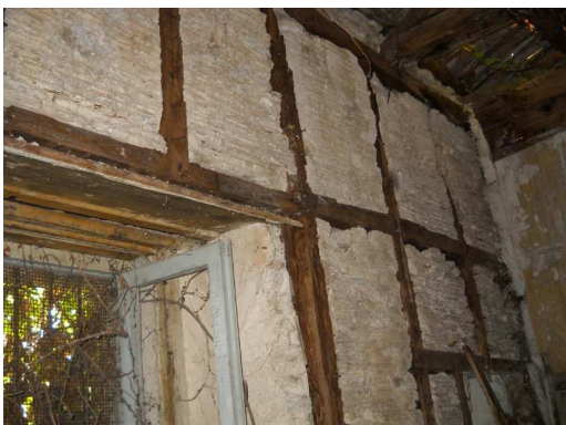
Fig. 1 - Mileto (Vv), fine XVIII secolo. Edificio realizzato secondo il regolamento antisismico borbonico.
